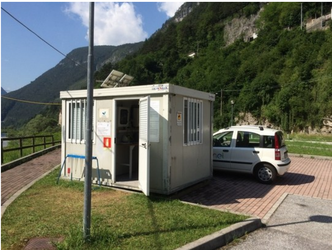
Box ENEL ove sono stati ricoverati gli acquisitori in continuo
