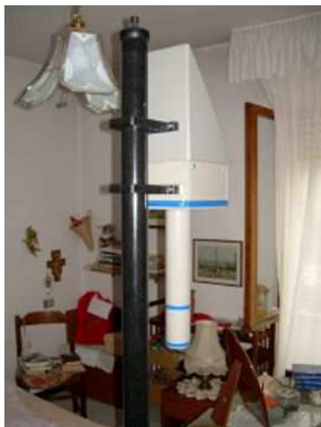
Foto del punto di misura
