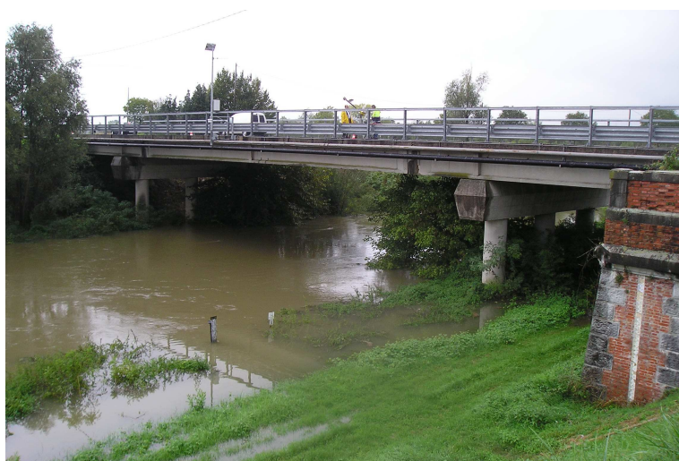
Foto 1 Livenza a Portobuffolè: misura di portata mediante argano (28 settembre 2007)
