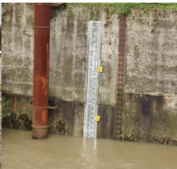
Foto 10 Malgher a Corbolone: particolare asta idrometrica (28 settembre 2007)
