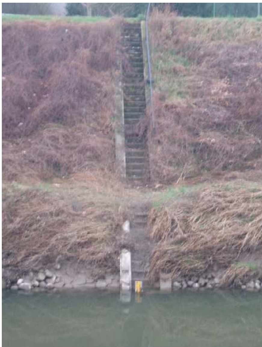
Foto 1 – Palladiana interrotta di Stanghella e asta idrometrica di magra
