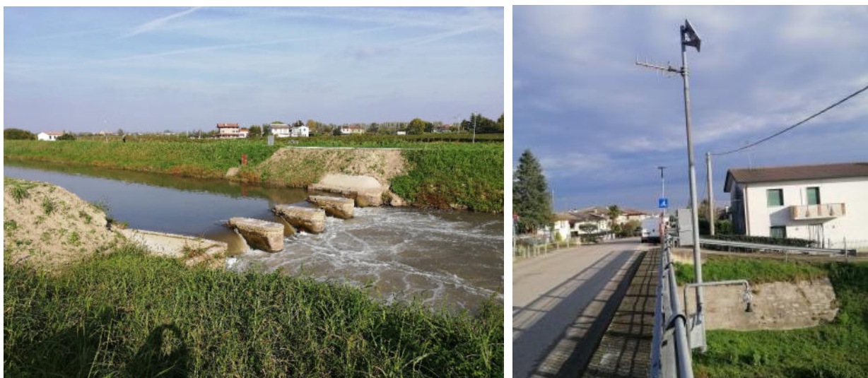
Figura 1 – A sinistra particolare dell’opera di sostegno di Valbonella (senza parzializzazione delle luci). A destra la stazione di misura del livello idrometrico di San Salvaro.
