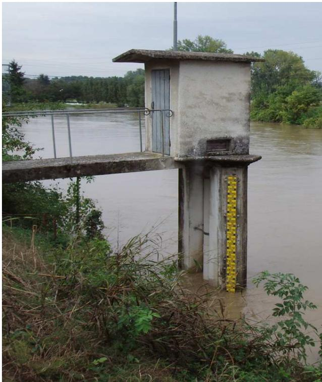
**Foto 3** – Alloggiamento Idrometrografo
