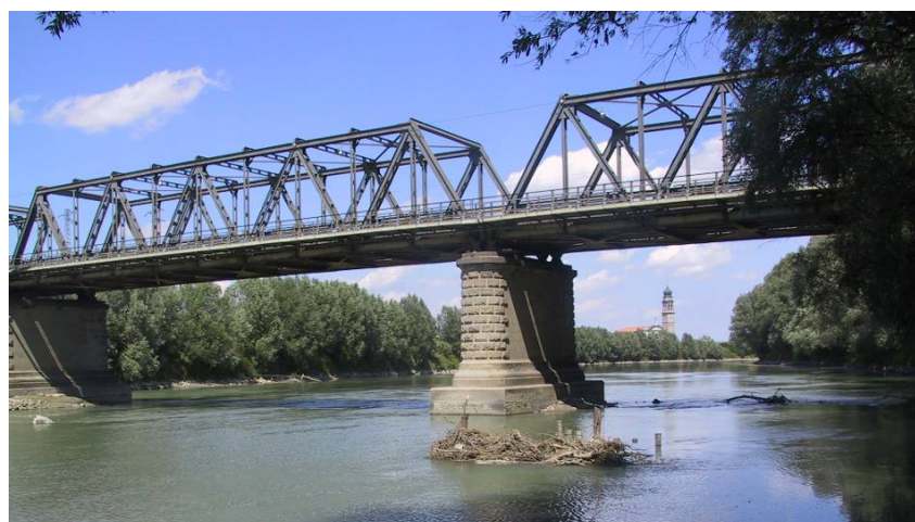
Figura 2. Panoramica del ponte di Boara sul fiume Adige
