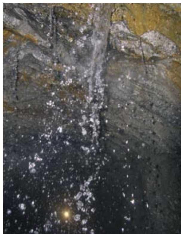
Figura 22. Miniere di Pian da Barco. Venute d'acqua nei cunicoli minerari e patine di ossidazione per la presenza di mineralizzazioni.
