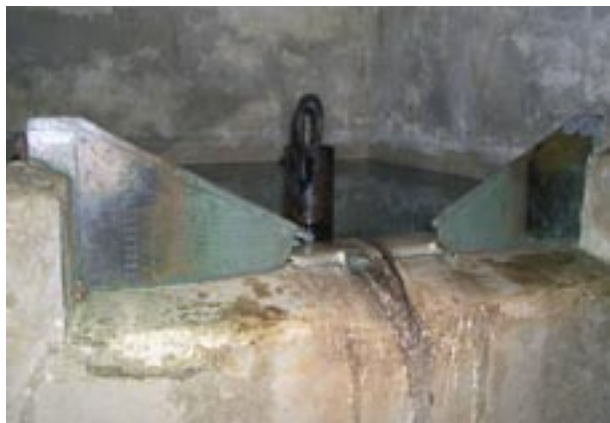
Figura 14. Vecchio stramazzo triangolare, a 90 gradi, con indicati i valori di portata. Sorgente Cava, Provincia di Belluno.
