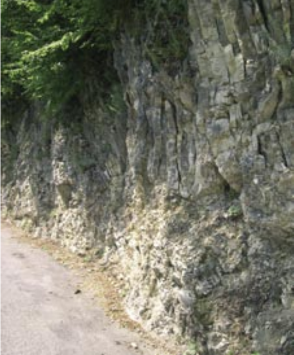
Figura 128. Ammasso roccioso altamente fratturato.
