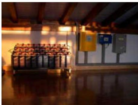
Foto 7. Parco a batterie in un impianto ad isola.
