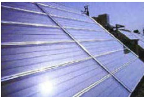
Foto 1 - Esempio di collettore solare piano vetrato
