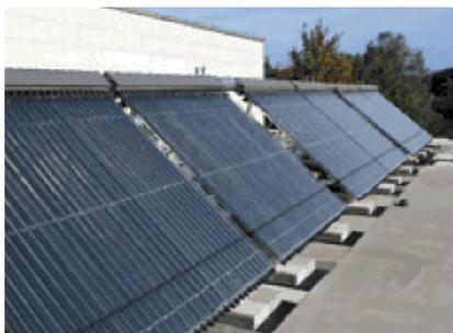
Foto 2 - Collettore solare sottovuoto
