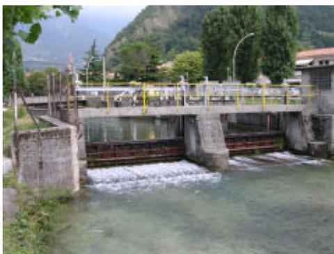
Foto 1 - Esempio di traversa: fiume Meschio a Serravalle di Vittorio Veneto.
