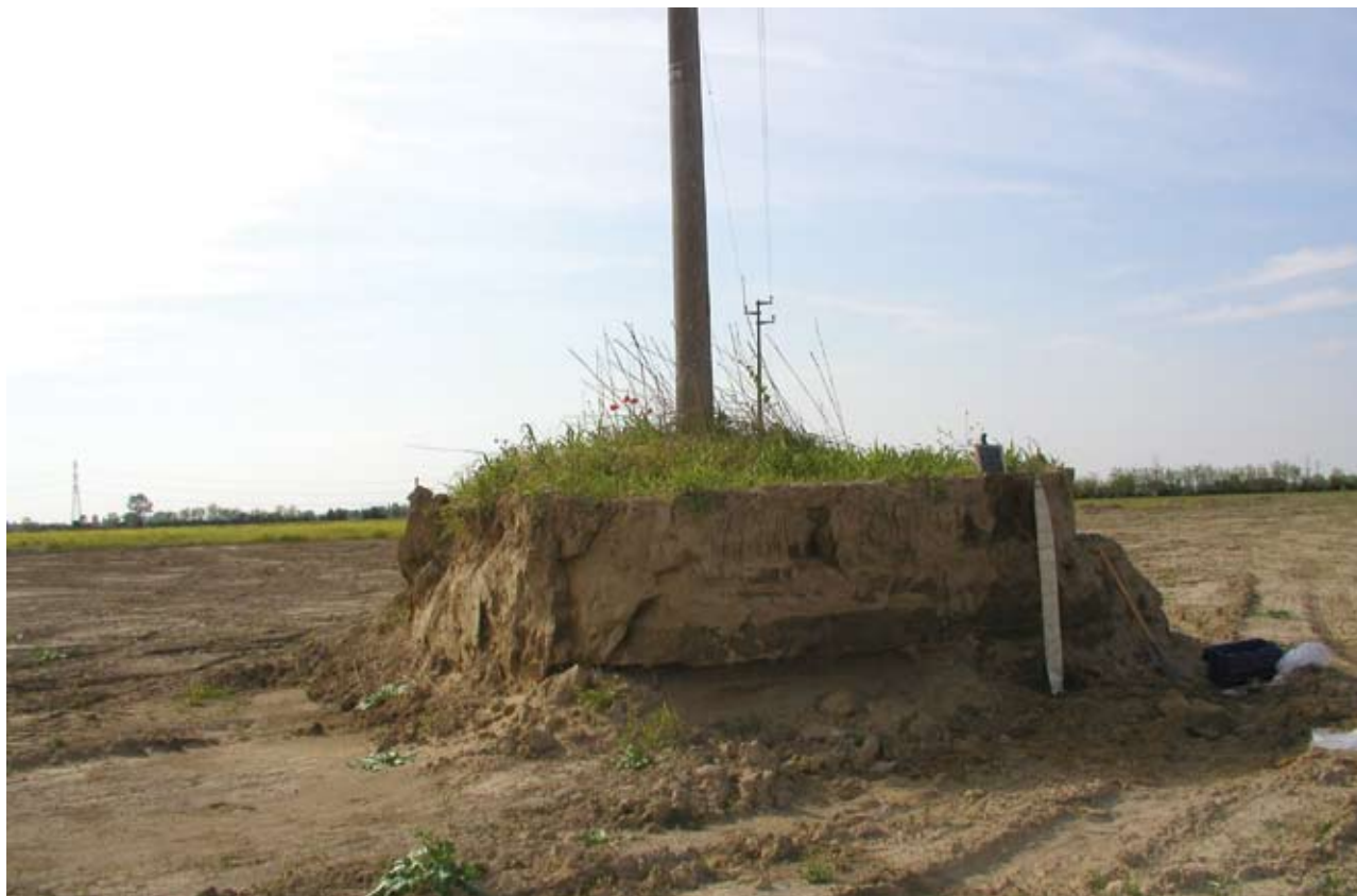
Fig. 1.6: Abbassamento del piano di campagna di circa 1,5 m nell'ambito di una miglioria fondiaria.
