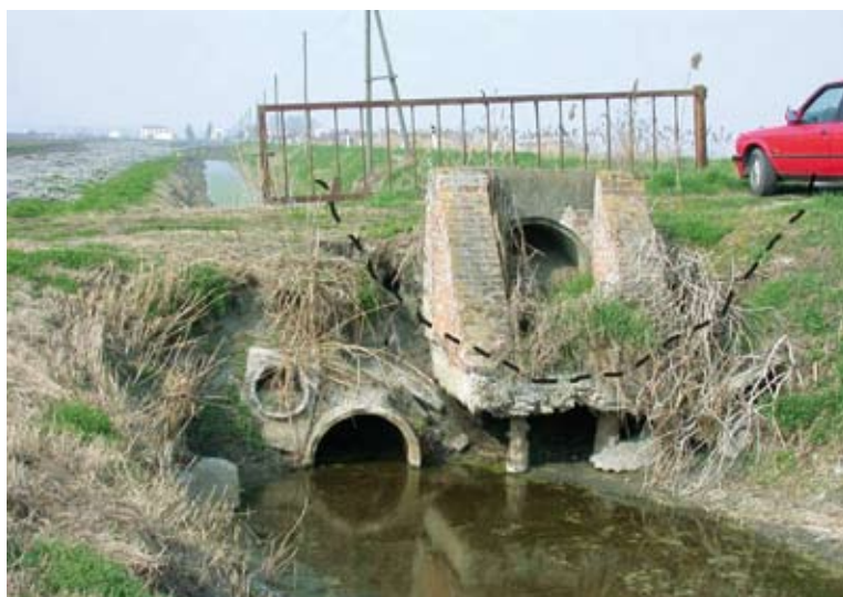
Fig. 1.3: Condotta di collegamento sotterranea a mattoni attualmente sopra il livello dell'acqua e sostituita da due tubi di scolo in cemento collocati più in basso, il più elevato dei quali risulta già inutilizzabile. La linea tratteggiata raffigura l'ubicazione originale della sezione della vecchia condotta (fonte Consorzio di Bonifica Adige Bacchiglione).
