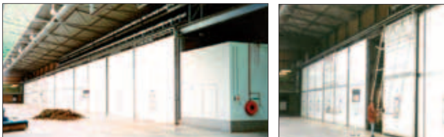
Fig. 3.71- Batteria di biocelle con in evidenza i portoni scorrevoli. Anche questa soluzione può garantire la tenuta necessaria per evitare scambi gassosi con l'esterno [foto: GICOM].
