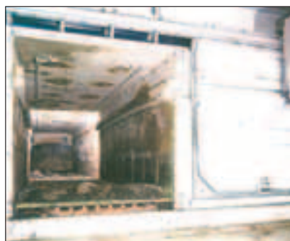
Fig. 3.68 - Particolare di interno di una biocella HORSTMANN con in evidenza sul soffitto le bocchette di aspirazione dell'aria e le tubazioni di umidificazione del prodotto.
