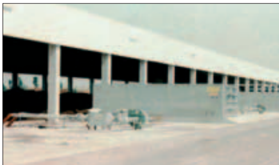
Fig. 3.9 - Impianto di aspirazione dell'aria dal capannone in un impianto aperto con in evidenza i ventilatori radiali e sulla destra la struttura del biofiltro.
