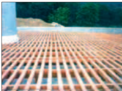
Fig. 4.8 - Pavimentazione di un biofiltro realizzata in grigliato di legno.
