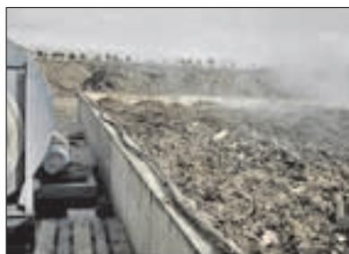
Fig. 4.16 - Biofiltro con pareti in c.a. gettate in opera.
