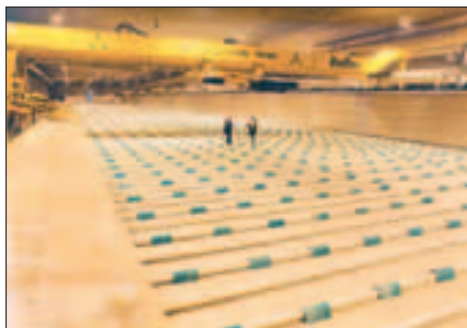
Fig. 3.41 - Impianto a bacino in fase di realizzazione con in evidenza la predisposizione a pavimento delle tubazioni per la ventilazione forzata [foto: SCT].
