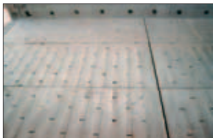
Fig. 3.55 - Pavimentazione prefabbricata a fori [fonte: HERHOF].
