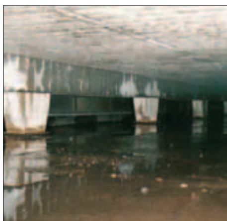
Fig. 3.58 - Camera di espansione dell'aria in una biocella a pavimentazione mobile [foto: CHRISTIAENS].
