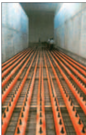
Fig. 3.56 - Diffusori dell'aria in una biocella in fase di costruzione [foto: HORSTMANN].
