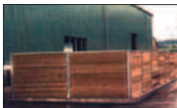
Fig. 4.15 - Biofiltro con pareti in pannelli di legno (a sinistra) e in c.a. (a destra) prefabbricati. [foto: GIAT ENG.].
