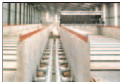
Fig. 3.33 - Impianto con predisposizione per la ventilazione forzata: in evidenza le zone in grigliato nella pavimentazione e la tubazione di mandata dell'aria [foto: EMMEPI].
