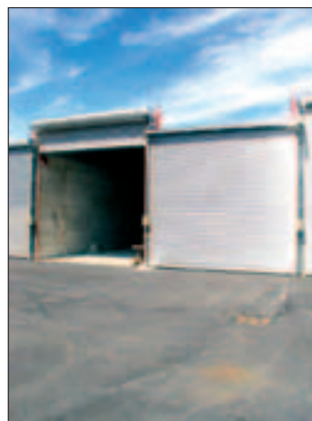
Fig. 3.80 - Biocelle statiche THÖNI da interno e da esterno con in evidenza i due sistemi di chiusura: a tenda e a tapparella.
