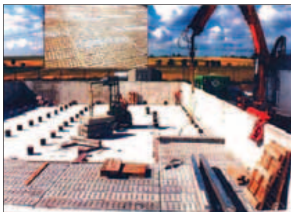
Fig. 4.10 - Biofiltro con pavimentazione in grigliato di c.a.: in evidenza anche le colonnine di supporto degli elementi prefabbricati [foto: GIAT ENG.].
