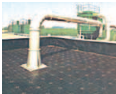
Fig. 4.9 - Pavimentazione prefabbricata in elementi modulati di materiale plastico [fonte: ECODECO].
