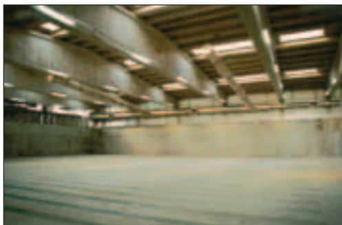
Fig. 3.42 - Impianto a platea con in evidenza il pavimento con i canali di insufflazione di aria e l'impianto di aspirazione dell'aria [fonte: HORSTMANN].
