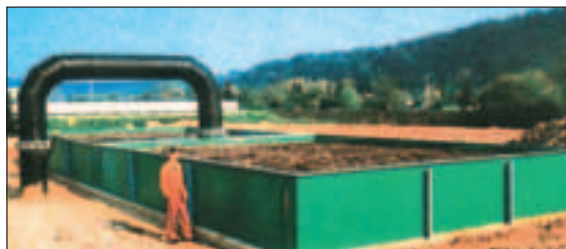
Fig. 4.14 - Biofiltro in pannelli prefabbricati d'acciaio verniciato [foto: THOLANDER].
