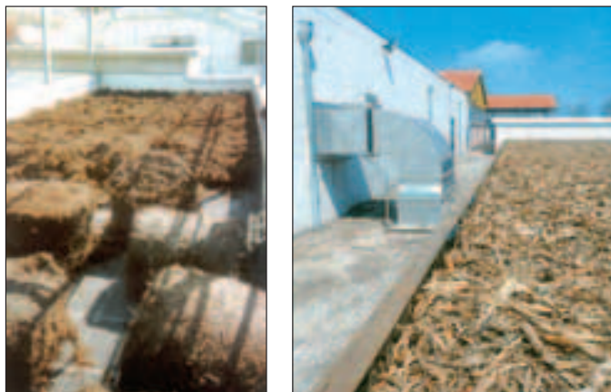
Fig. 4.7 - Biofiltri con materiale filtrante costituito da torba a sinistra [foto: AIRCLEAN] e in stocchi di mais e cippato di legno a destra [foto: HORSTMANN].
