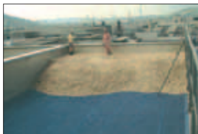
Fig. 4.13 - Biofiltro il fase di riempimento con in evidenza il telo filtrante di interfaccia tra pavimentazione e materiale filtrante [foto: THÖNI].
