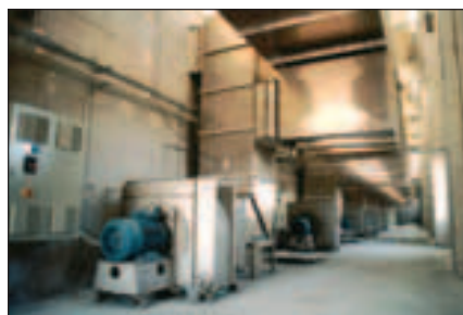
Fig. 3.66 - Impianto di aerazione di un complesso di biocelle [foto: HERHOF e HORTSMANN].
