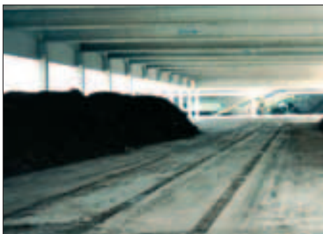
Fig. 3.7 - Capannone "aperto" per il compostaggio in cumuli aerati: in evidenza (a sinistra) il canale coperto da grigliato per l'ossigenazione della massa.
