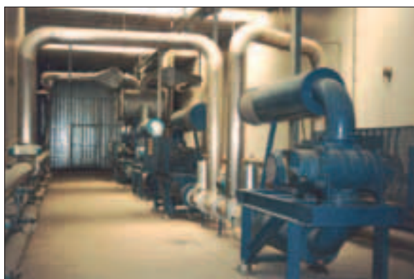
Fig. 3.86 - Impianto di aerazione di un tunnel SIT.
