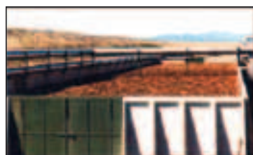
Fig. 4.15 - Biofiltro con pareti in pannelli di legno (a sinistra) e in c.a. (a destra) prefabbricati. [foto: GIAT ENG.].
