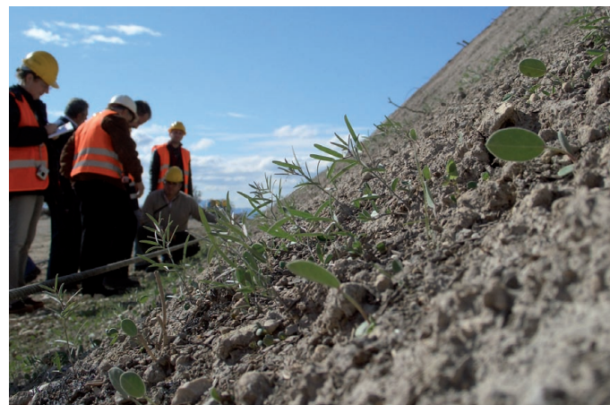
Applicazione di compost in una cava con la tecnica dell'idrosemina e attecchimento della vegetazione.
