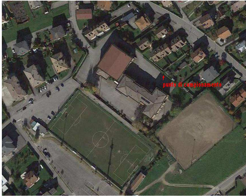
Posizionamento mezzo mobile
