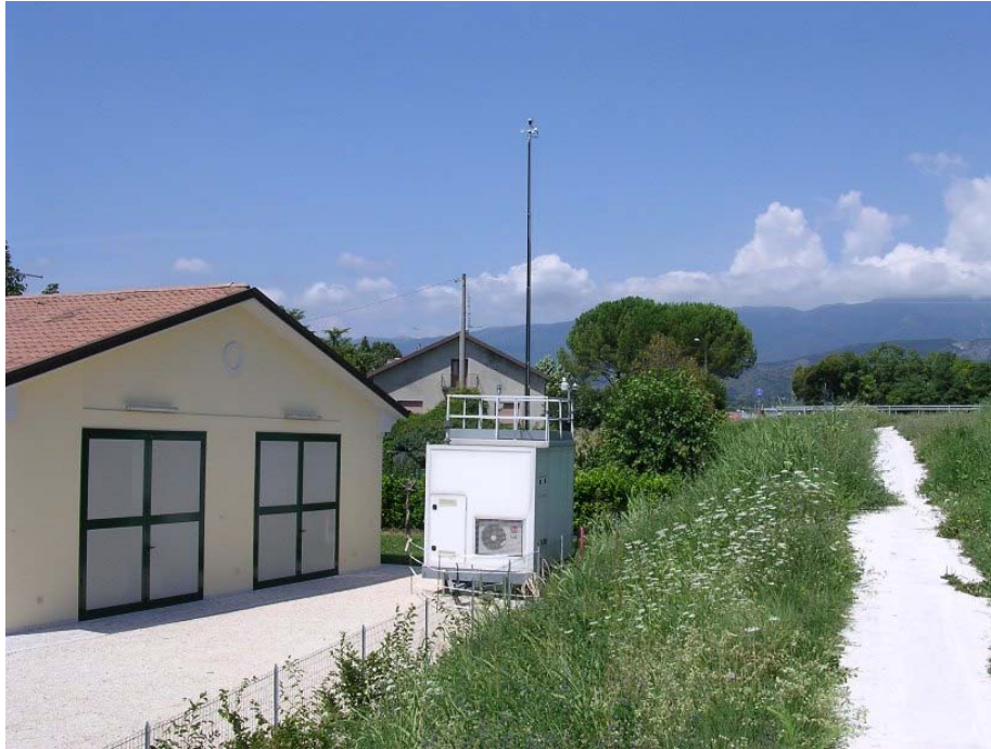
Foto 1: Stazione rilocabile posizionata a Cappella Maggiore
