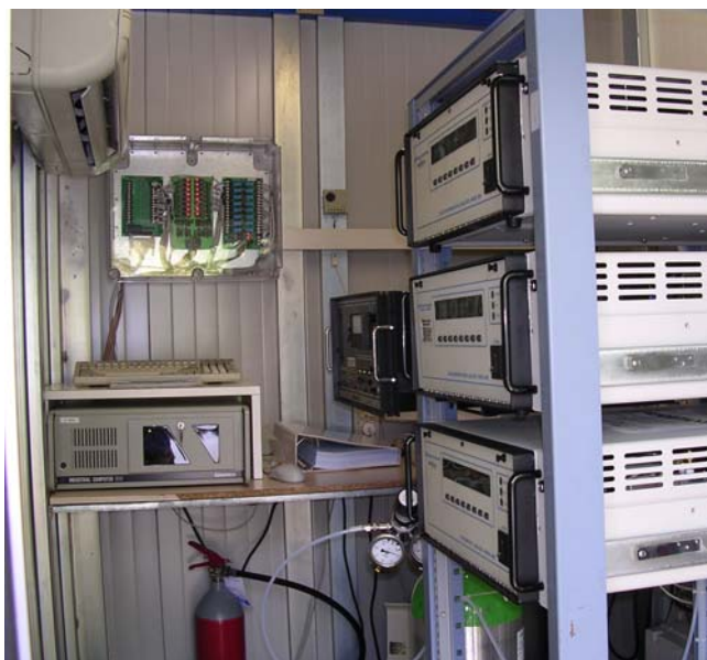
Foto 2: Stazione di Conegliano via Kennedy, interno.
