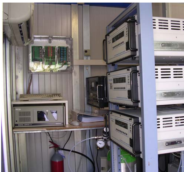
Foto 2: Stazione di Conegliano via Kennedy, interno
