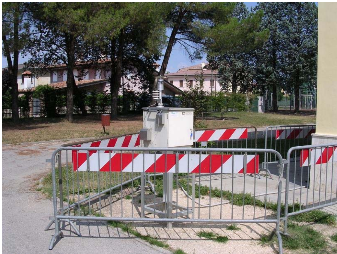
Foto 1 Campionatore portatile posizionato nel comune di Spresiano in Via Montello presso le scuole elementari
