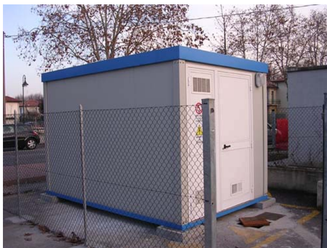
Stazione di via Lancieri di Novara
