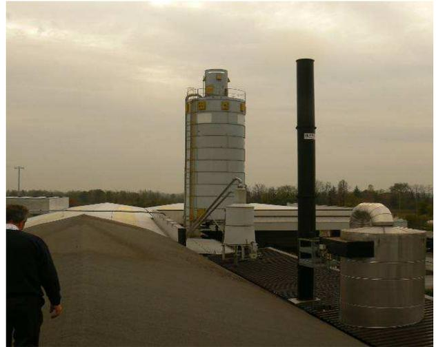
FOTO 2 – Sistema di trasporto e alimentazione del combustibile
