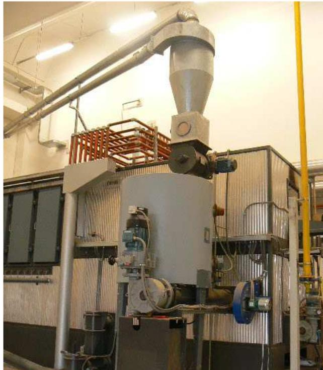
FOTO 3 – Sistema di alimentazione e regolazione dell'aria comburente
