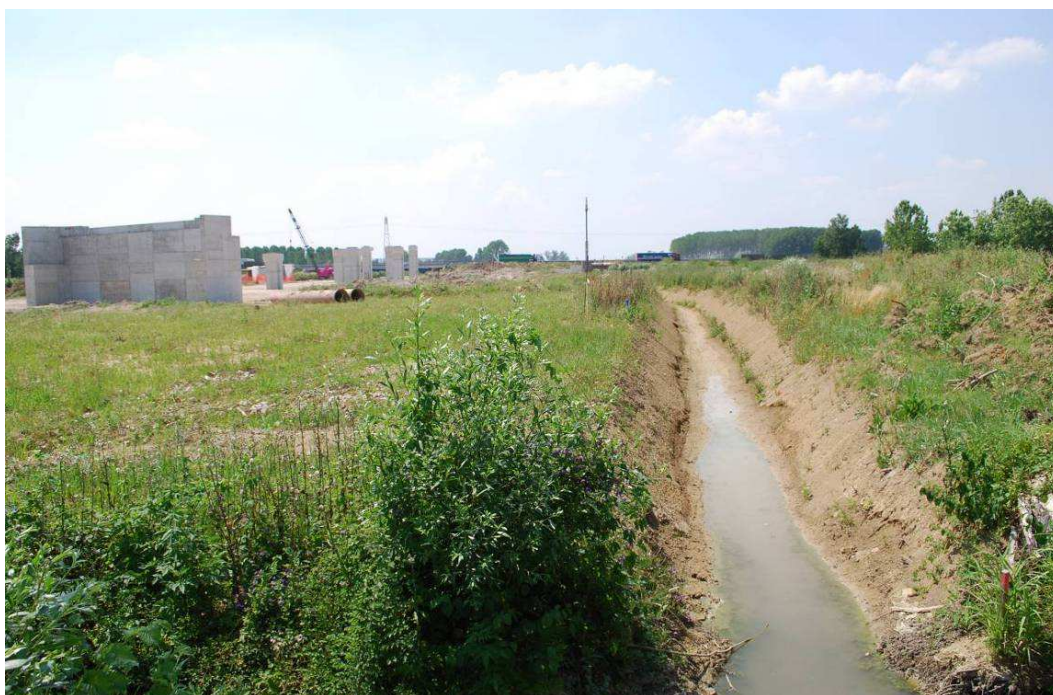
Foto 1 e 2. Stato dei luoghi in corrispondenza del cantiere Nord al momento del sopralluogo 20/06/2013.
