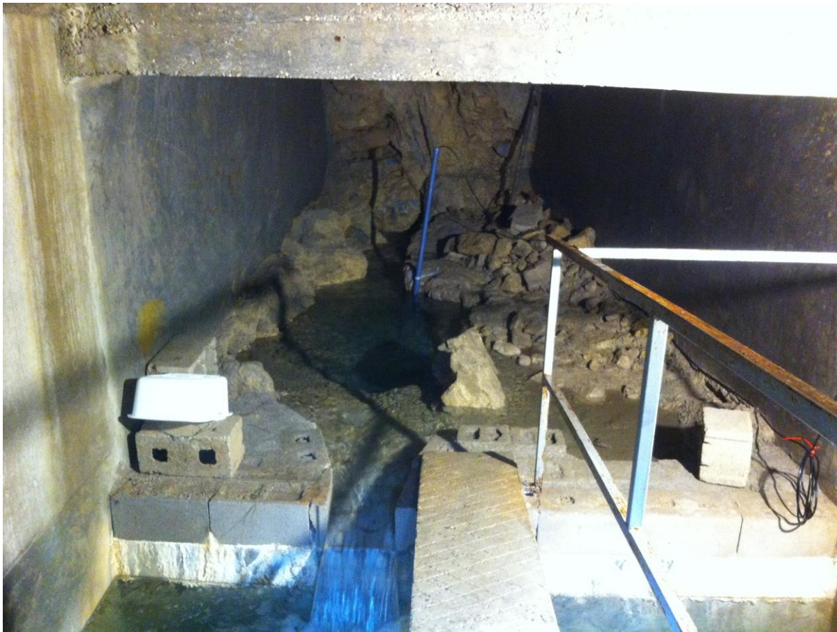
Fig. 1 Sorgente Laron. Si nota in primo piano la soglia di sfioro con a monte la pozza naturale da cui emerge l'acqua e il tubo azzurro in cui è alloggiata la sonda.
