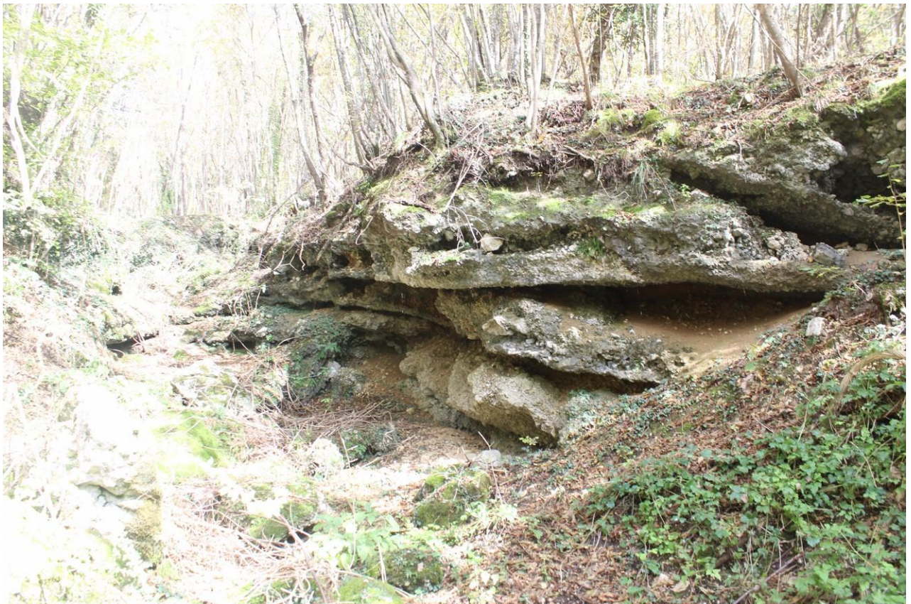
Fig. 19 Incisione nel pendio entro i detriti cementati e stratificati che con il loro angolo di riposo danno l'inclinazione del versante.
