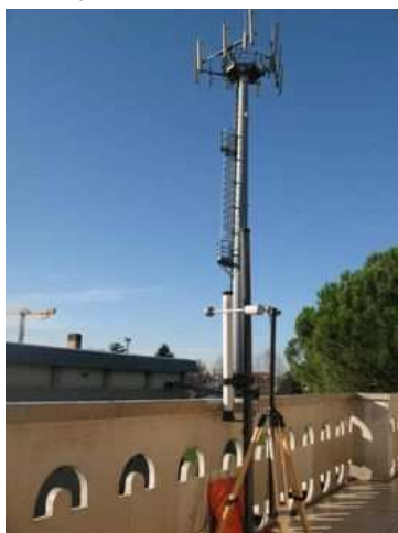
Foto del punto di misura
