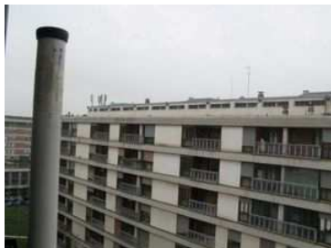
Foto del punto di misura
