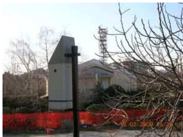
Foto del punto di misura
