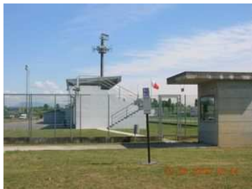
Foto del punto di misura
