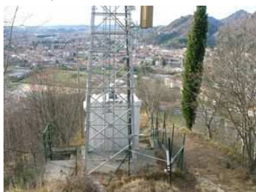
Foto del punto di misura
