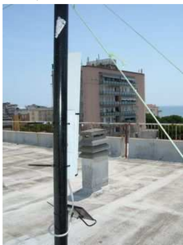
Foto del punto di misura
