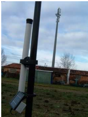
Foto del punto di misura
