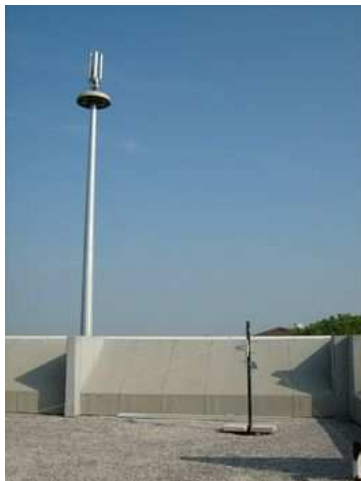
Foto del punto di misura
