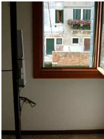
Foto del punto di misura
