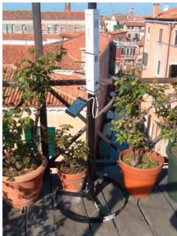
Foto del punto di misura
