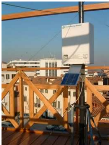
Foto del punto di misura
