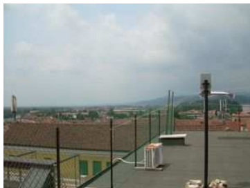
Foto del punto di misura
