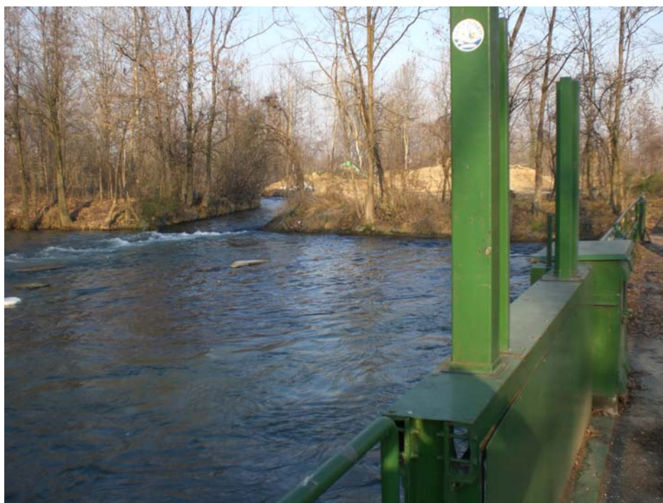
Figura 13. Vasca di accumulo e ripartizione delle portate tra lo Scarico Forca e la Roggia Dolfina Bernarda
