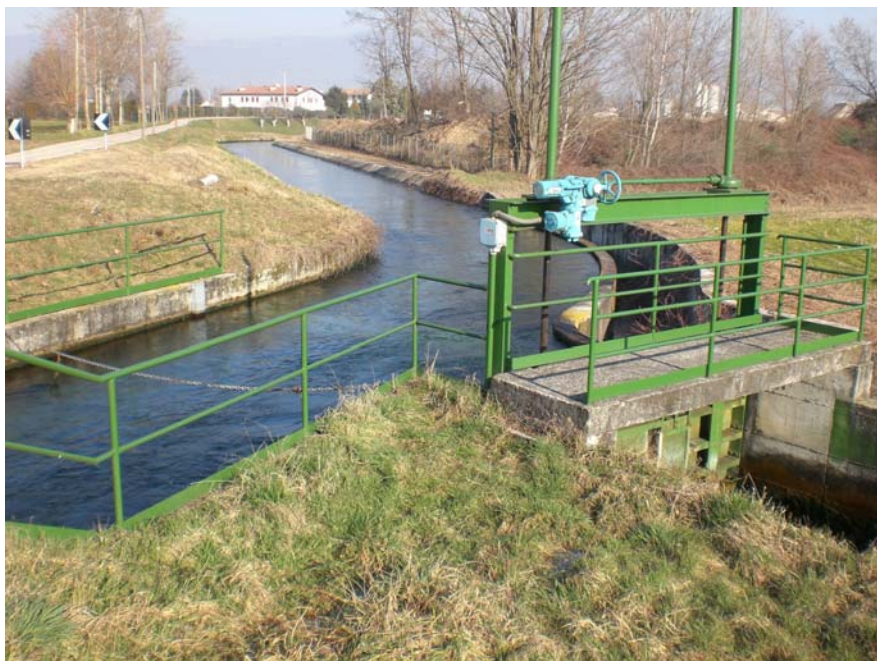
Figura 12. Opere idrauliche presenti presso lo Scarico Piona localizzato in comune di Nove lungo il corso della Roggia Isacchina.
