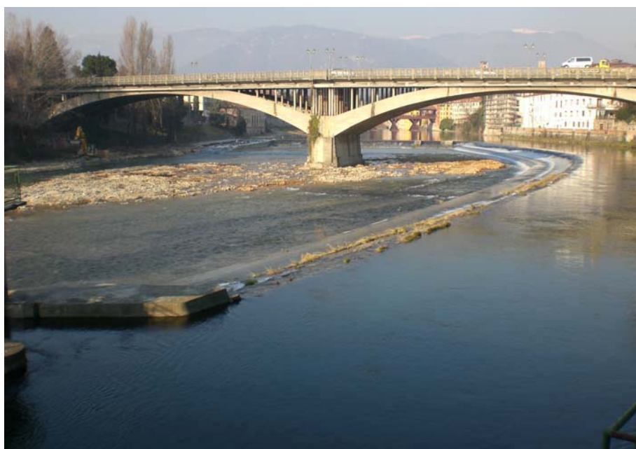
Figura 5. Opera di presa Porte Colomba – Ponte della Vittoria. Punto di alimentazione principale della rete irrigua del Consorzio di Bonifica Pedemontano Brenta.
