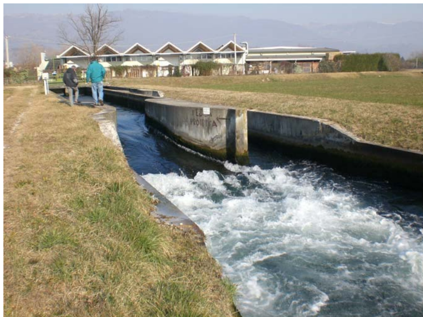
Figura 9. Misuratore a risalto sul Canale Unico ubicato immediatamente a valle della diversione della Roggia Isacchina.
