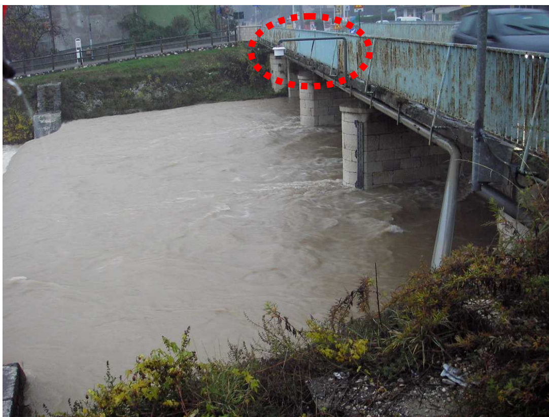
Figura 2 – Torrente Agno a Ponte Brogliano: teleidrometro ad ultrasuoni fissato al centro del ponte
