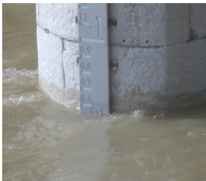
Figura 3 – Torrente Agno a Ponte Brogliano: asta idrometrica installata su una pila del ponte; condizioni di magra (foto a sinistra) e di morbida (foto a destra)
