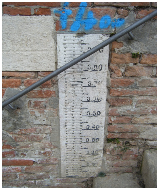
Figura 3 – Fiume Frassine a Borgofrassine: asta idrometrica storica, sul muro d'ala sinistro del ponte, lato di valle
