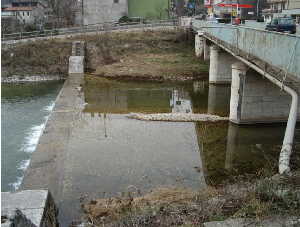
Figura 14 – Torrente Agno: stazione idrometrica di Ponte Brogliano in periodo di magra (16/02/2005: 0.34 m 3 /s)
