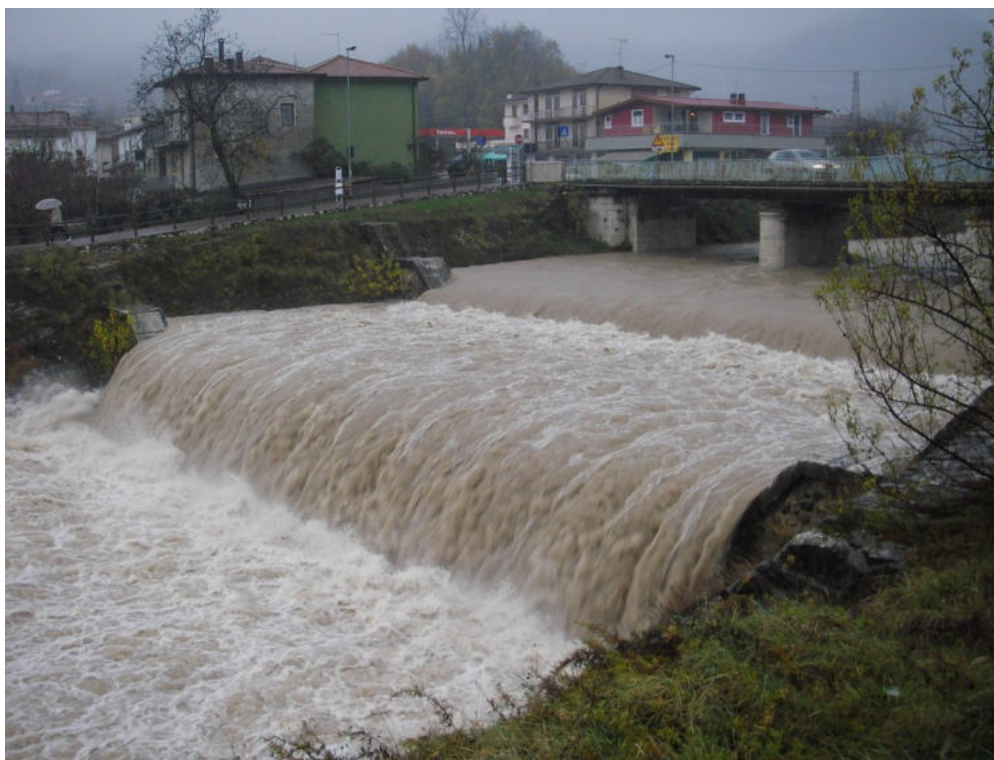
Figura 13 – Torrente Agno: stazione idrometrica di Ponte Brogliano in concomitanza del passaggio di un evento di piena (05/05/2010: 46.05 \text{ m}^3/\text{s} )
