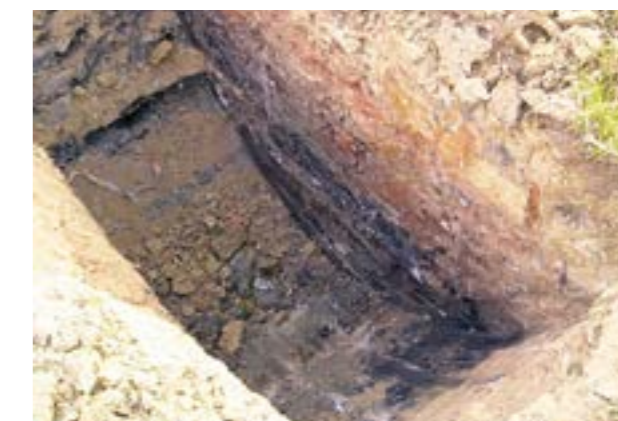
Fig. 1.3: Sito contaminato da sostanze d'origine industriale.
