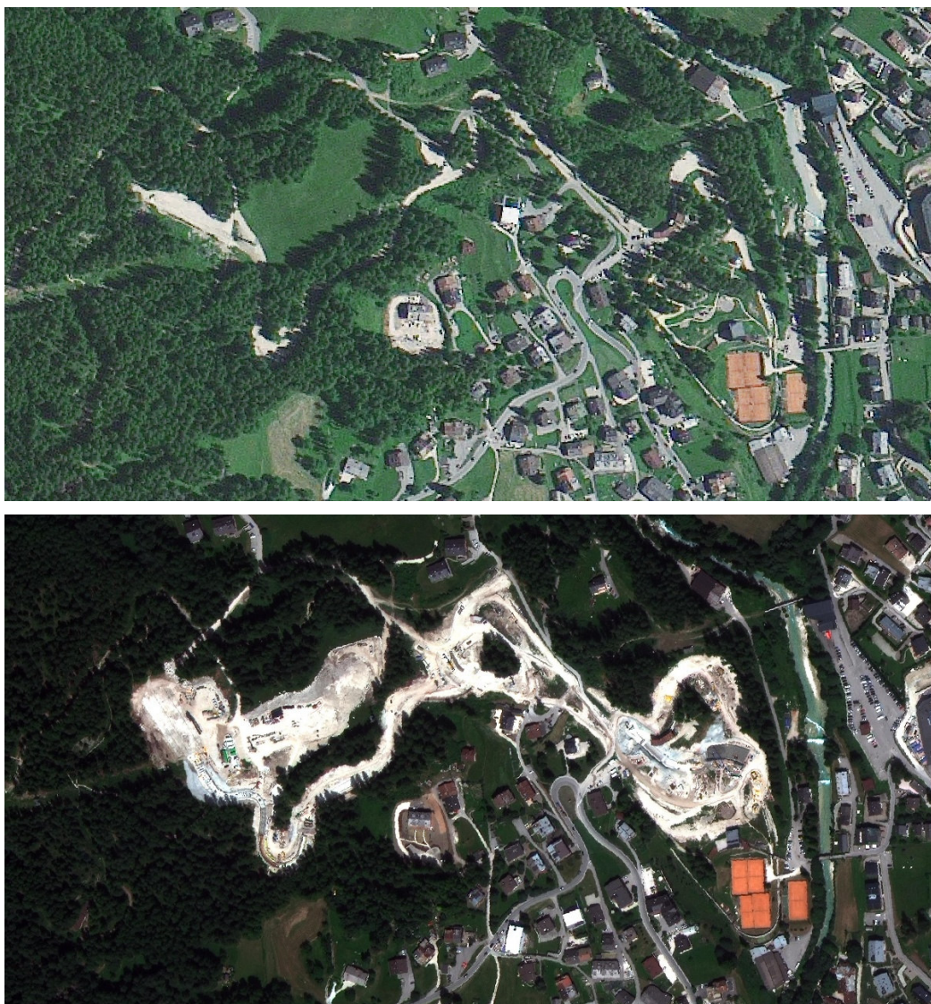
Fig. 2.1: Cantieri su circa 5 ettari di superficie per la pista da bob a Cortina d'Ampezzo (immagine 2023 Triplesat sopra e luglio 2024 Gaofen SV-2 Regione Veneto, sotto).
