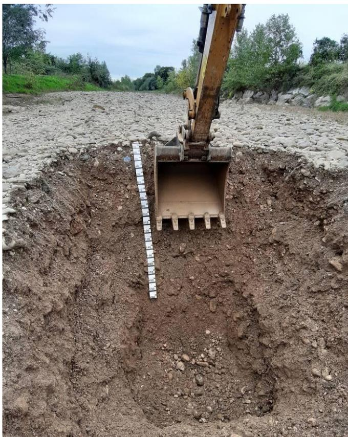
Figura 9: Scavo dei sedimenti ghiaiosi in alveo dove, in assenza di acqua, è stato possibile campionare fino alla profondità di 200 cm.
