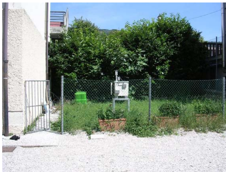
Foto 1: Campionatore rilocabile posizionato a Cavaso del Tomba in Via S.Pio X presso le scuole elementari in località Vettorazzi.
